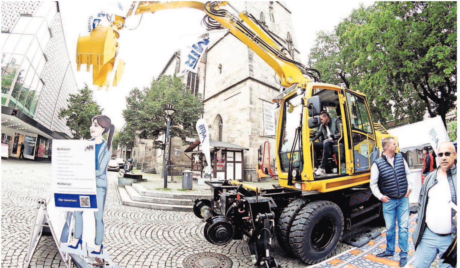
Die Baufirma MTB aus Nordstemmen ist spezialisiert auf Eisenbahnbauwerke und ist mit einem Gleisbaubagger angerückt.
